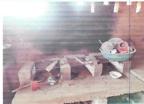
FOTO 2: ESTUFA EN MAL ESTADO Y SIN CHIMENEA
